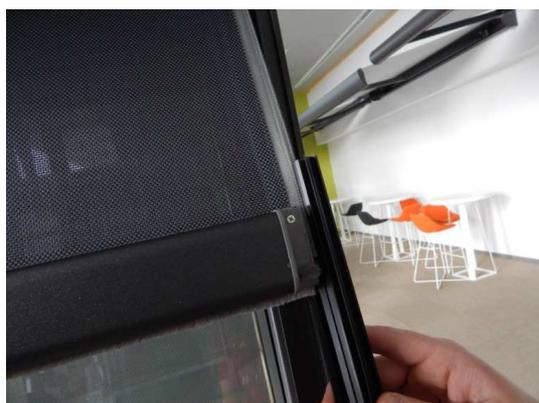
7. Führen Sie den Reißverschluss in das Führungsprofil.
