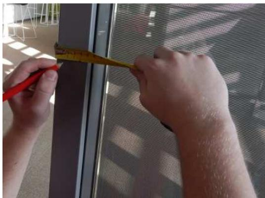
5. Bestimmen Sie die Position der zweiten Führungsschiene. Wiederholen Sie die Schritte analog zur ersten Führungsschiene.
