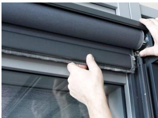
6. Stecken Sie die Kassette mit den Zapfen auf die Führungsschienen.
