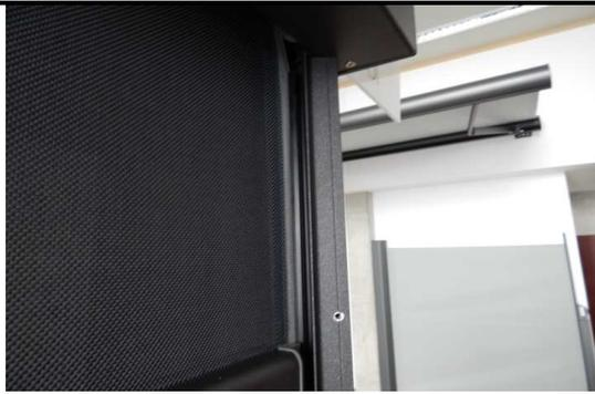
9. Stecken Sie das Führungsprofil in den festen Teil der Führungsschiene und setzen anschließend den beweglichen Teil der Führungsschiene darauf.
