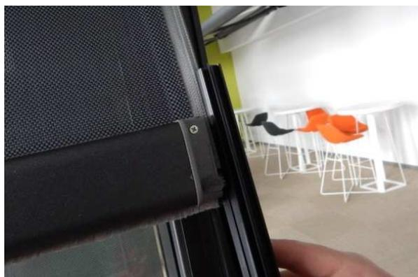
9. Führen Sie den Reißverschluss an den Stoffseiten in das Führungsprofil und stecken dieses in die Führungsschiene gemäß Abb. 4 und Zeichn. 13.
