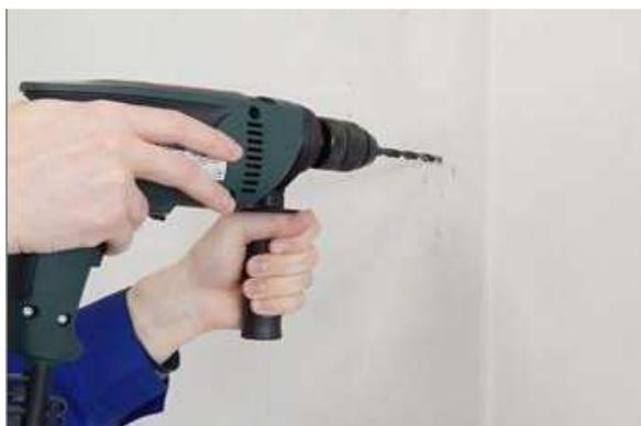
3. Bohren Sie die Löcher in die Wand.
