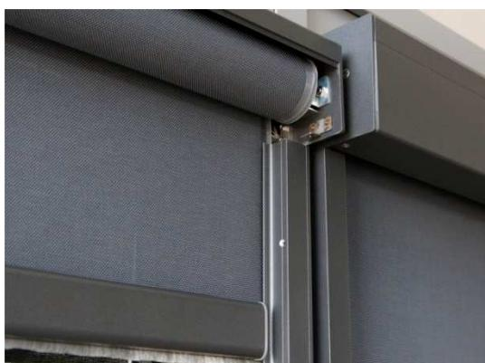
9. Stecken Sie das Führungsprofil in den festen Teil der Führungsschiene und setzen anschließend den beweglichen Teil der Führungsschiene darauf.
