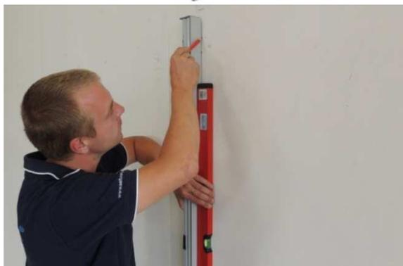
2. Messen und Markieren Sie die Bohrlöcher für die Unterputzkassette.
